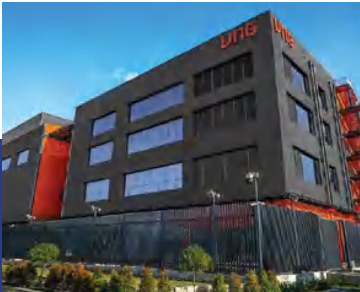
VNG Data Center
